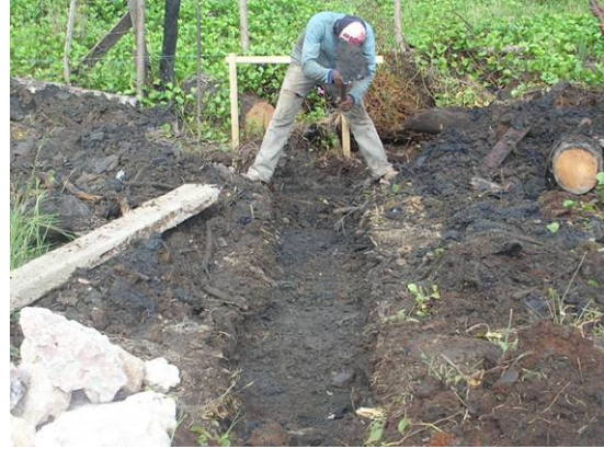
De fundering wordt uitgegraven
