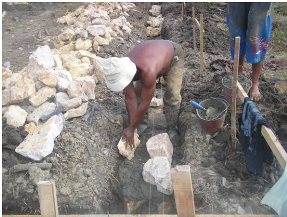
De fundering wordt gelegd.
