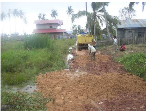
De weg wordt aangelegd...
